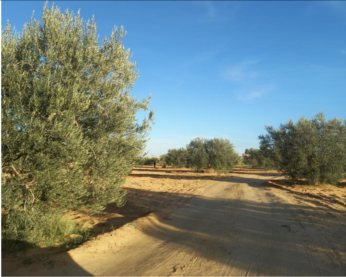
Figure 10 : Emprise des travaux d'aménagement de la Piste reliant Route Chorfa et GP2
