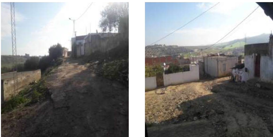
Figure 5: Exemple de points à fort danger à la zone du projet
