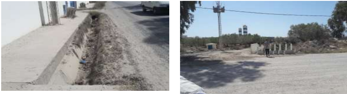
Figure 4: Exemple d'ouvrages hydrauliques à la zone du projet
