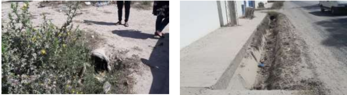
Figure 5 : Ouvrage de drainage d'eaux pluviales existant au niveau de la RL597
