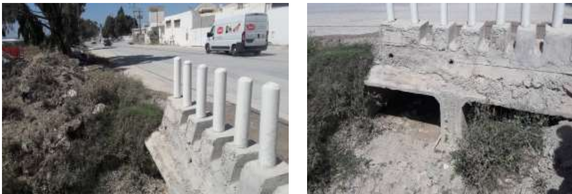
Figure 6 : Les 2 dalots 2x1 qui traversent la RL 597
