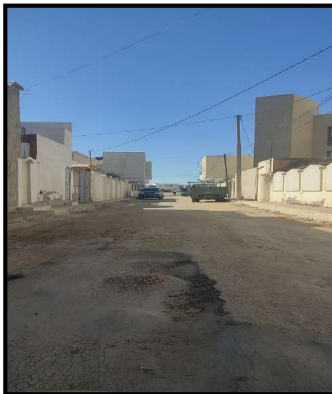
Figure 8: Bourrelet sur la voie
