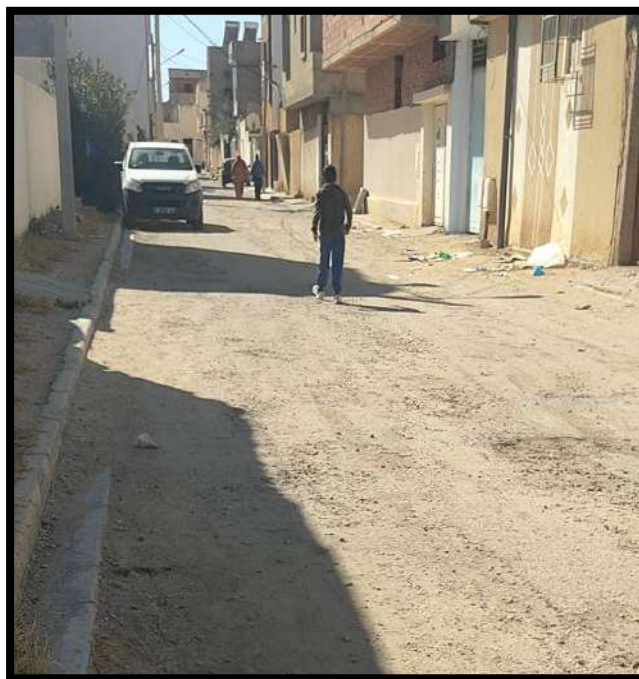
Figure 11: caniveau latéral en mauvais état
