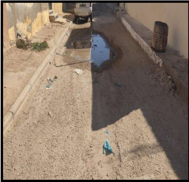
Figure 12: Problème de stagnation
