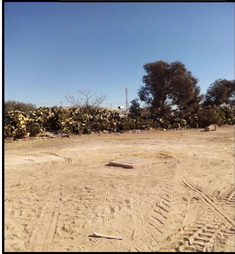
Figure 6: un réseau d'assainissement des eaux usées en bon état de fonctionnement. Implanté au milieu de l'impasse ce qui va compliquer l'exécution du réseau de drainage
