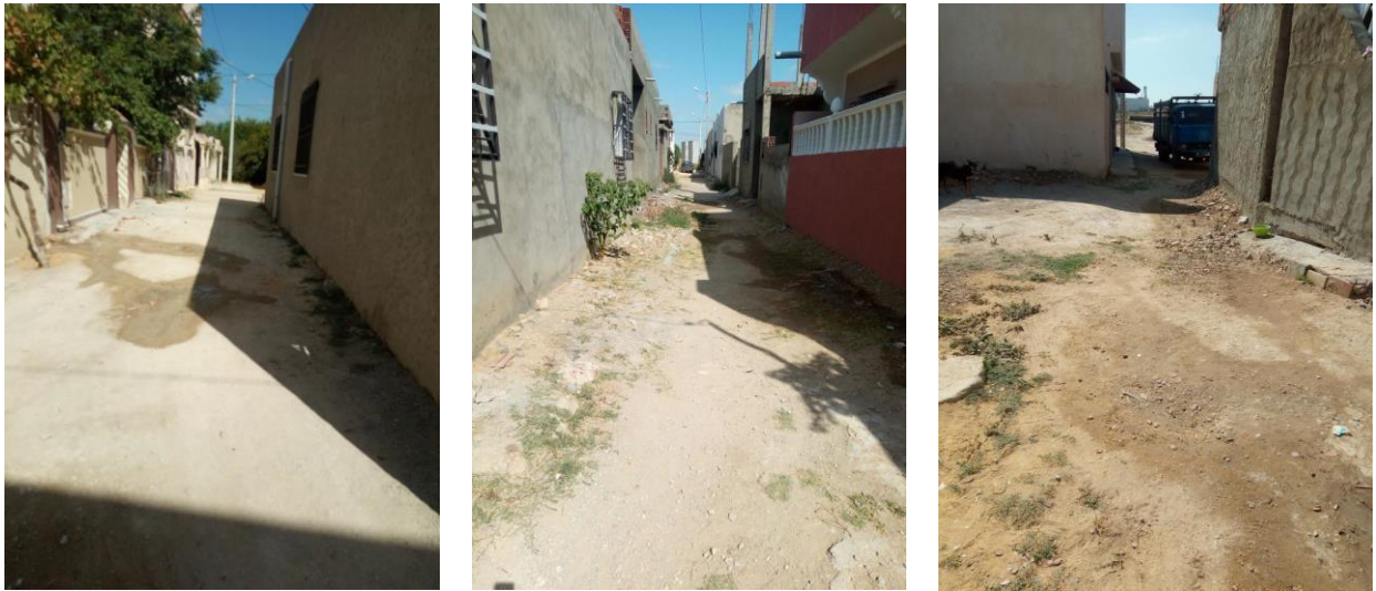
Figure 1 : Etat des lieux de la voirie / Zone El Argoub 1 (voirie en terre bâtie)
