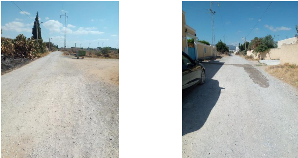
Figure 2 : Etat des lieux de la voirie / Zone El Argoub 2 (voirie en terre bâtie)
