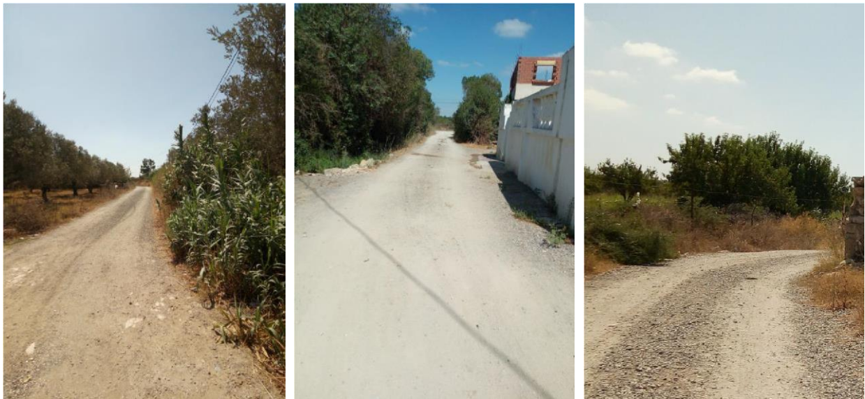
Figure 4 : Etat des lieux de la voirie / Douar Bousen
