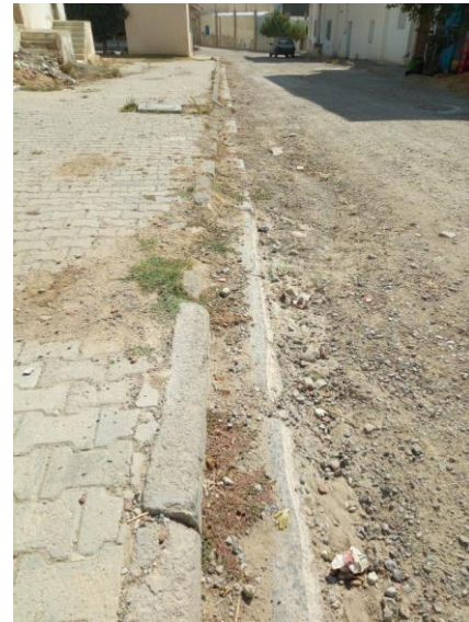
Figure 13 : Etat des lieux de la voirie / Aïne Tbornek (bicouche dégradé)
