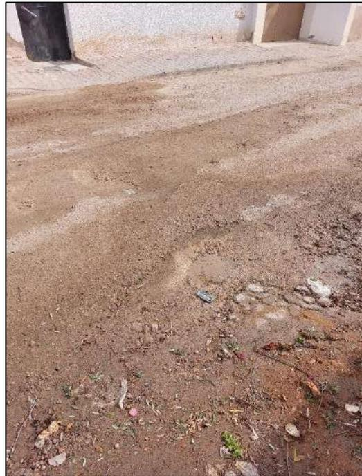
Dégradation profonde du corps de la chaussée
