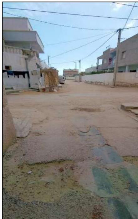
Caniveaux centraux dégradés – Ecoulement superficiel en difficulté
