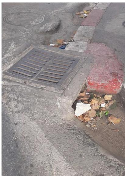
**Figure 7: Réseau d'évacuation d'eau pluviale**
