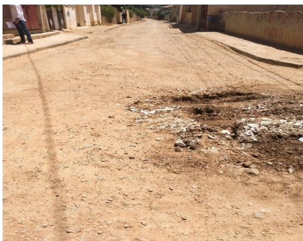
V2 : Chaussée en terrain nu
