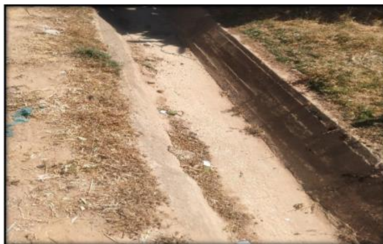
Figure 3: Fossé bétonné existant
