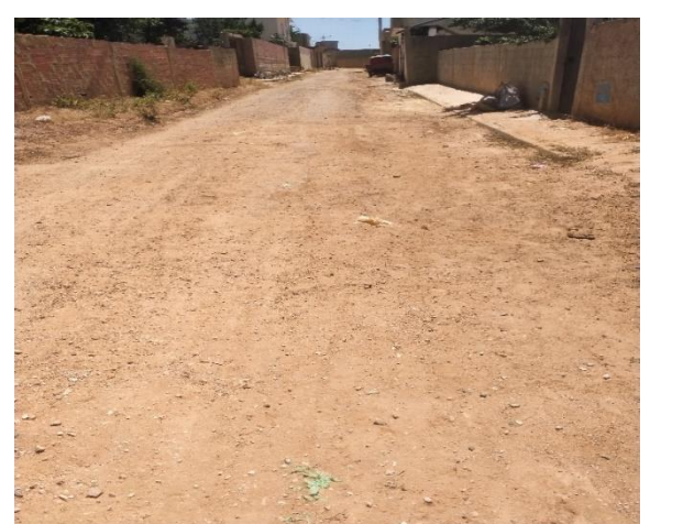
V3 : Chaussée en terrain nu
