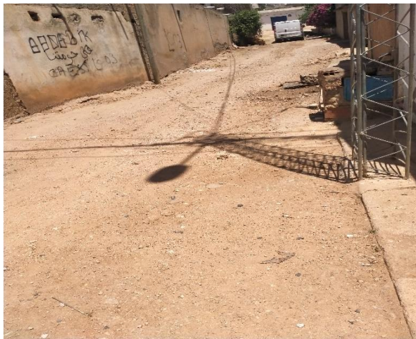
V1-2 : Chaussée en terrain nu
