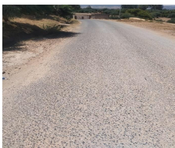
V5 : Chaussée en bon état
