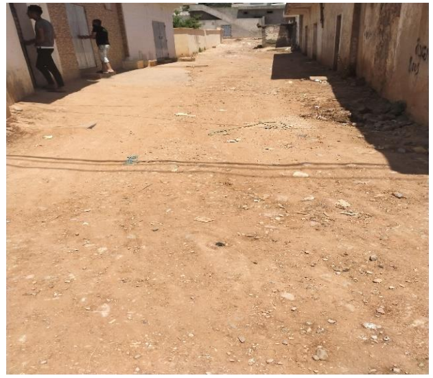
V1-1 : Chaussée en terrain nu
