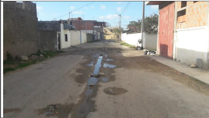
Photo n°11 : Vue de la voie n°32 au milieu
