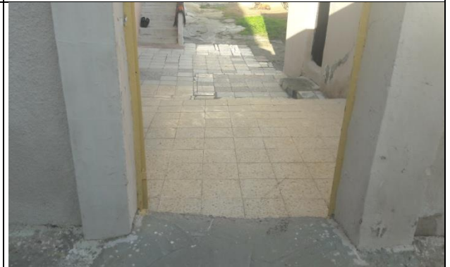
Photo n°20 : Niveau d'un seuil par rapport à la chaussée sur la voie n°01
