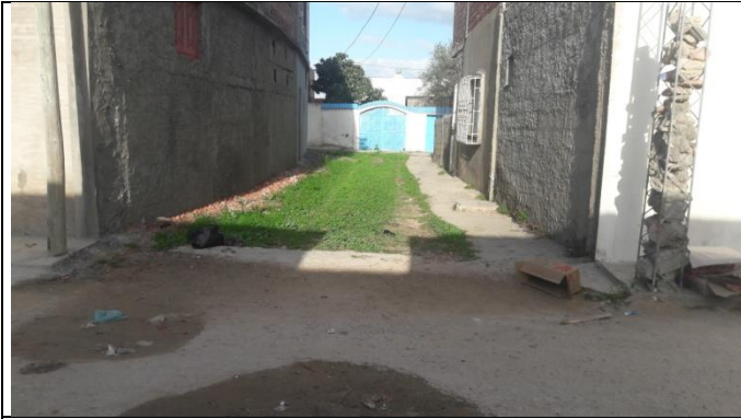
Photo n°09 : Vue de la voie n°30
