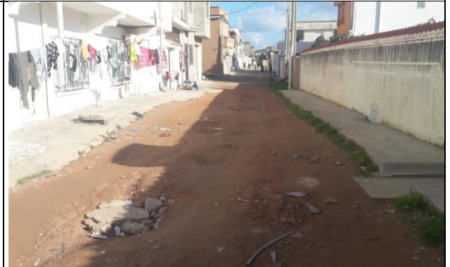
Photo n°24: Vue de la voie n°3.1 du côté de la voie 01
