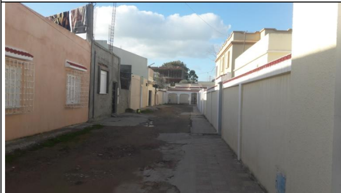
Photo n°13 : Vue de la voie n°32
