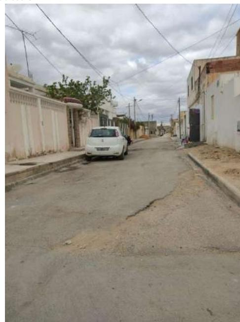
Figure 8: affaissement dans la tranchée
