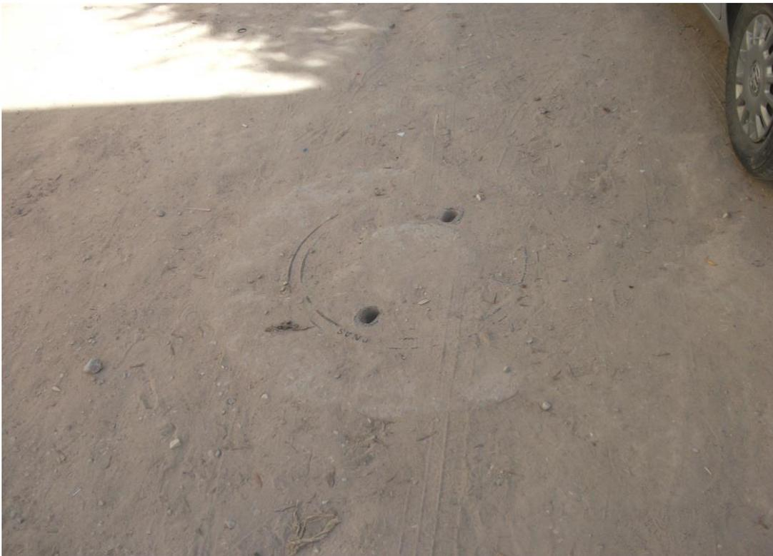
**Figure 8: Tous les logements de l'impasse sont desservis par un réseau d'assainissement des eaux usées en bon état de fonctionnement. Implanté au milieu de l'impasse ce qui va compliquer l'exécution du réseau de drainage.**
