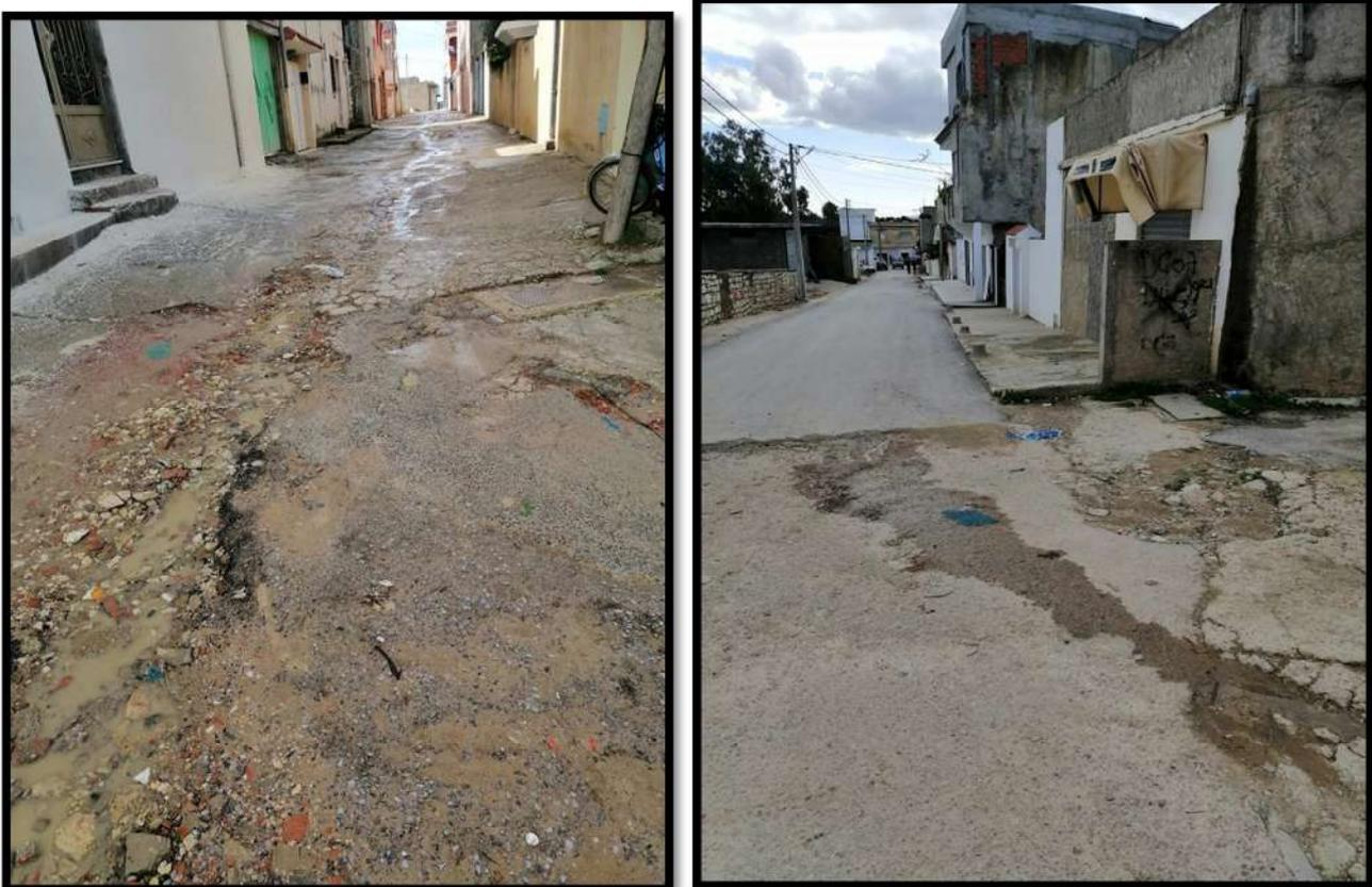
Figure 23 : affaissement dans la tranchée
