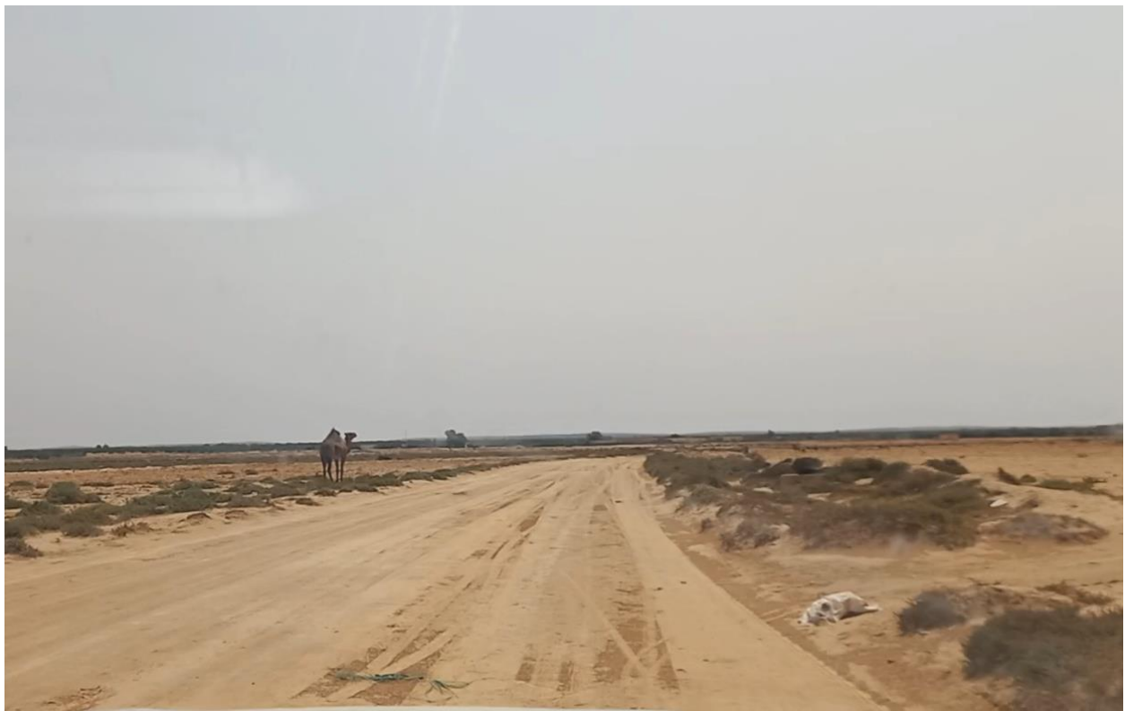
Figure 2: Etat actuel de la voirie dans les zone d'intervention
