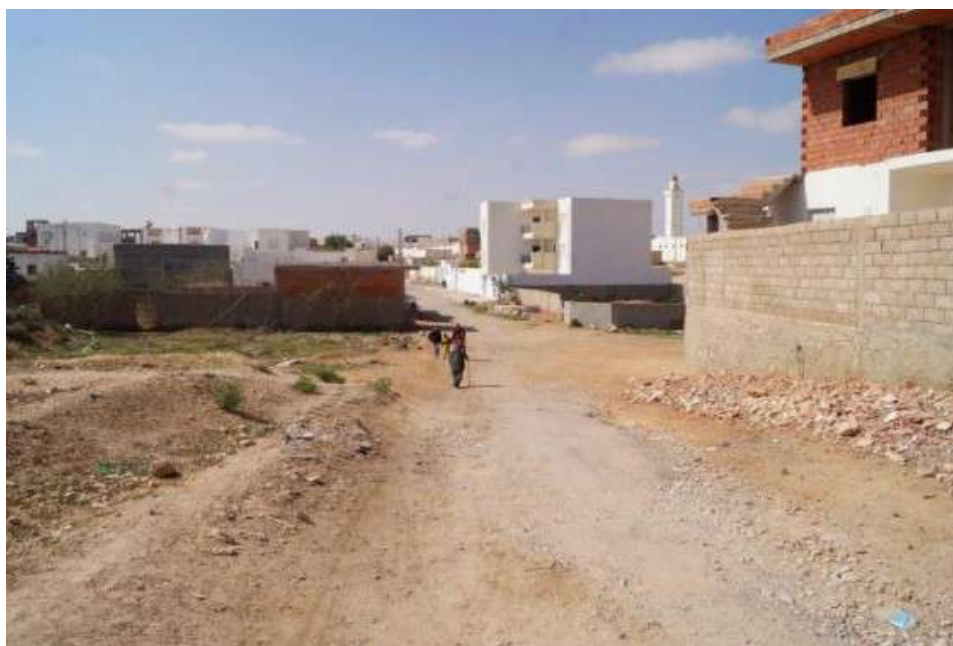
Figure 28.: Etat de piste-Terrain en pente –voie V3
