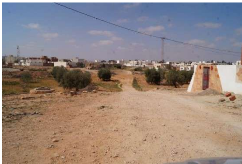
Figure 26.: Etat de piste-Pente-Passage par cour d'eau –voie V4
