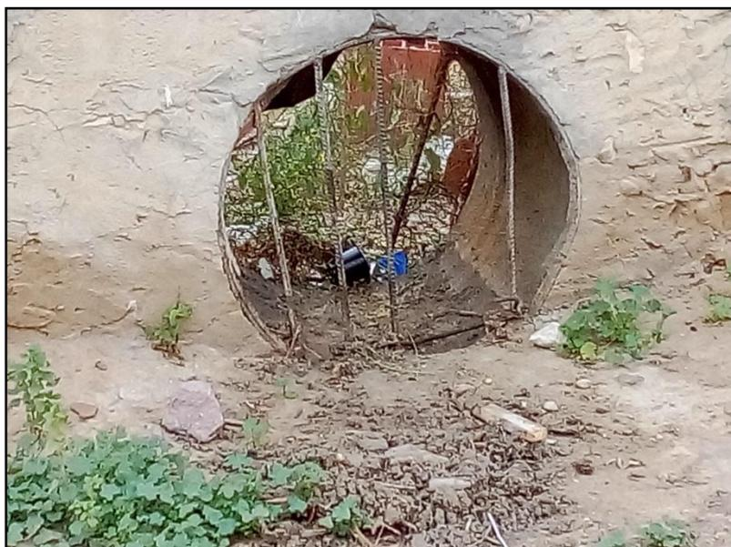
**Ouverture mur existante Ø600 permettant l'évacuation des eaux pluviales située à 157m à partir de l'extrémité de Rte GREMDA**
