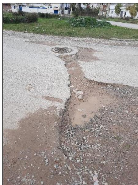
Dégradation de la chaussée au droit des tranchées d'eaux usées
