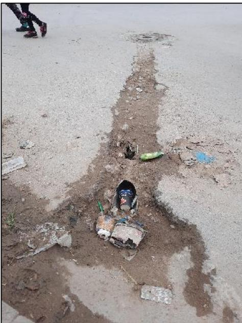
Dégradation de la chaussée au droit des tranchées – Tassement
