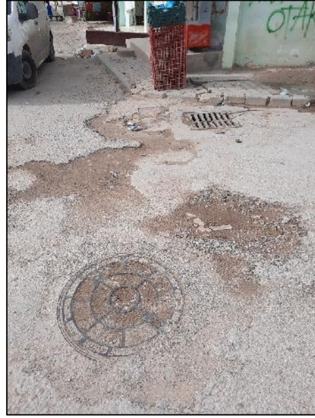
Usure et dégradation du revêtement
