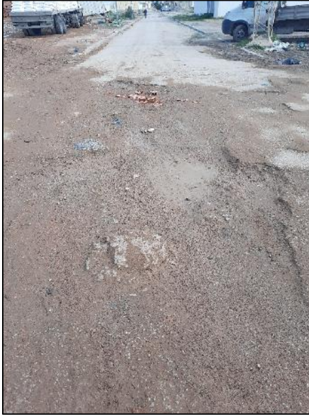
Usure et dégradation du revêtement
