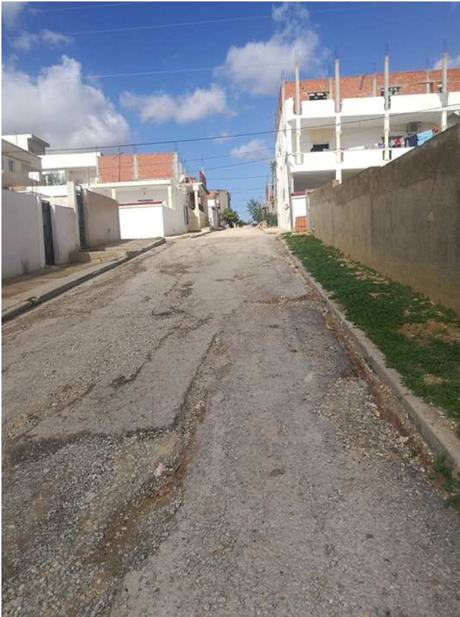
Figure 6: Désenrobage de la chaussée (endommagées)
