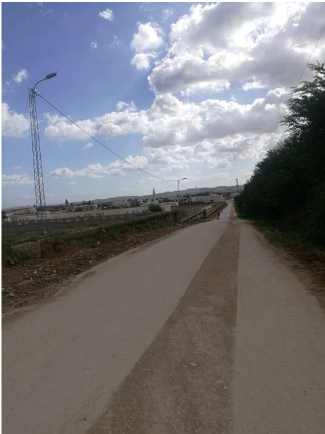
Figure 4 : affaissement dans la tranchée
