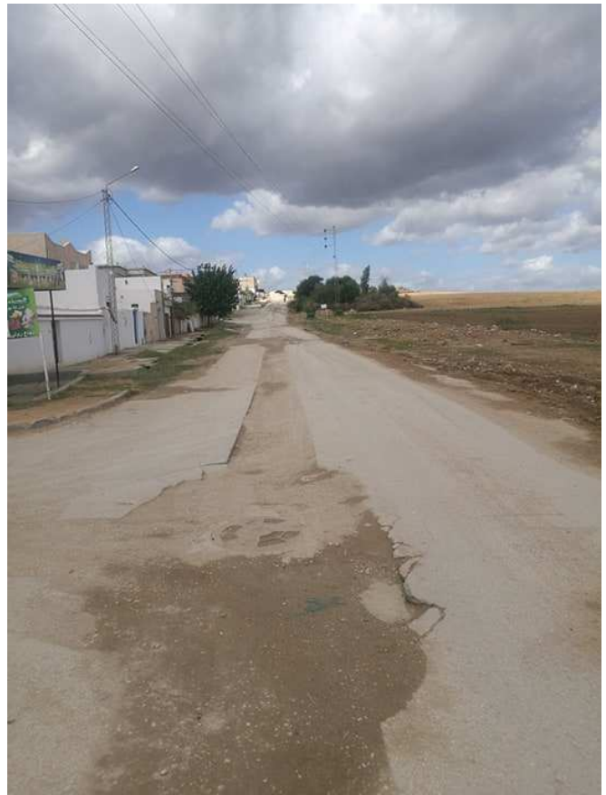
Figure 4 : affaissement dans la tranchée
