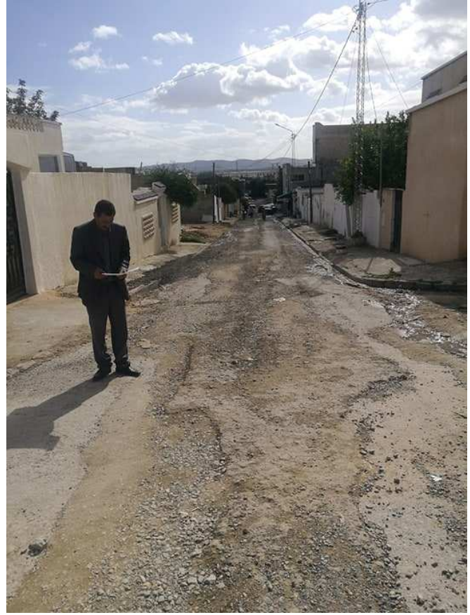
Figure 6: Désenrobage de la chaussée (endommagées)
