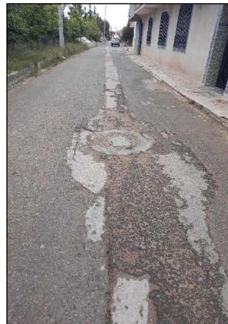
Dégradation de la chaussée au droit des tranchées d'eaux usées
