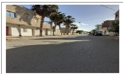
Photo 1 : chaussée en béton bitumineux type d'aménagement (N3)
