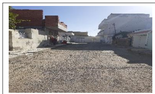
Photo 2 : Chaussée en bicouche type d'aménagement(N4)
