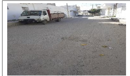
Photo 3 : chaussé en bicouche dégradé (N2) Photo 4 chaussé en béton bitumineux dégradé (N2)
