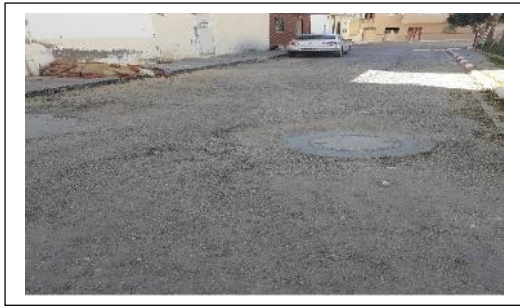
Photo 3 : chaussé en bicouche dégradé (N2) Photo 4 chaussé en béton bitumineux dégradé (N2)
