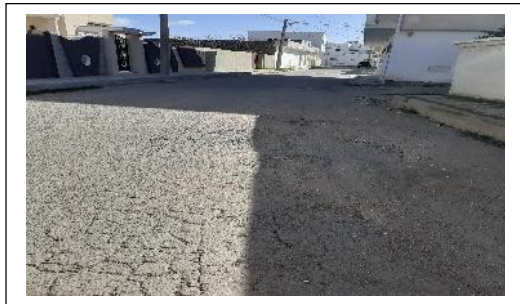
Photo 7 : chaussé dégradé sous l'effet des écoulements d'eau Photo 8 : Chaussé en cimentage
