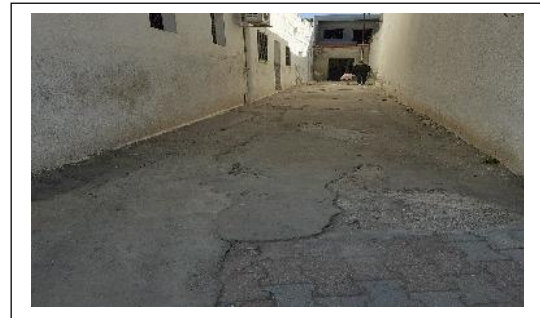
Photo 7 : chaussé dégradé sous l'effet des écoulements d'eau Photo 8 : Chaussé en cimentage
