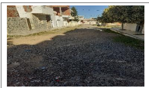
Voie 1 : Chaussée en bicouche très dégradée Voie 2 : Chaussée en bicouche très dégradée
