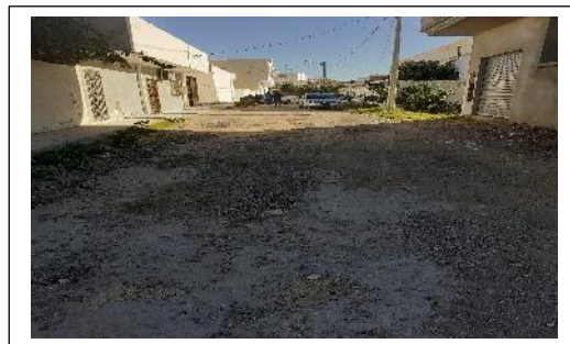
Voie 1 : Chaussée en bicouche très dégradée Voie 2 : Chaussée en bicouche très dégradée
