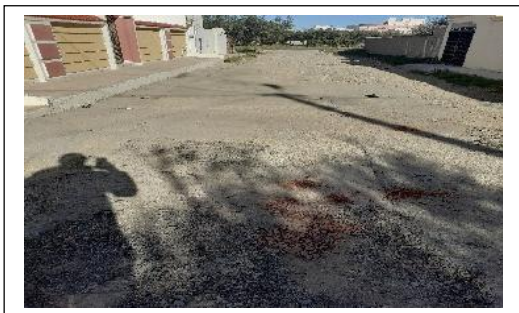
Voie 1 : Chaussée en bicouche très dégradée Voie 2 : Chaussée en bicouche très dégradée
