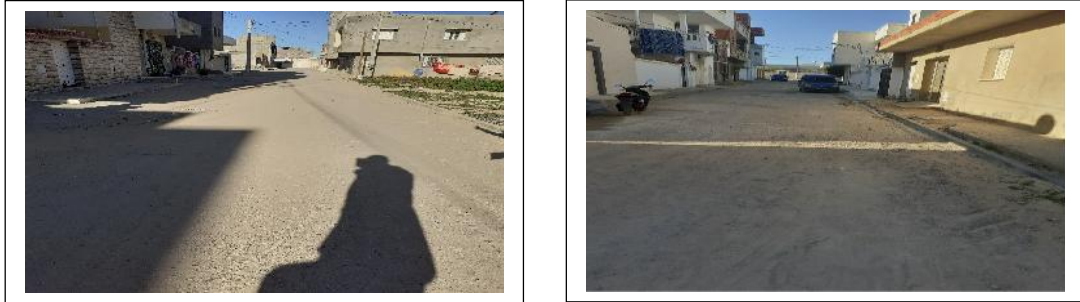
Voie 17 : Chaussée en bicouche dégradée Voie 18 : Chaussée en bicouche dégradée
