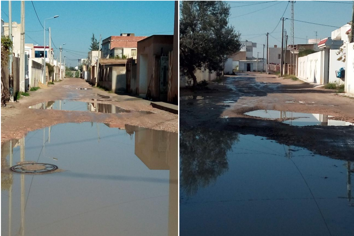
Figure 8 :Les voies présentent des grandes surfaces de stagnation des eaux pluviales
