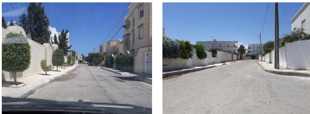
Figure 3: Etat des lieux de la voirie : travaux de réhabilitation
