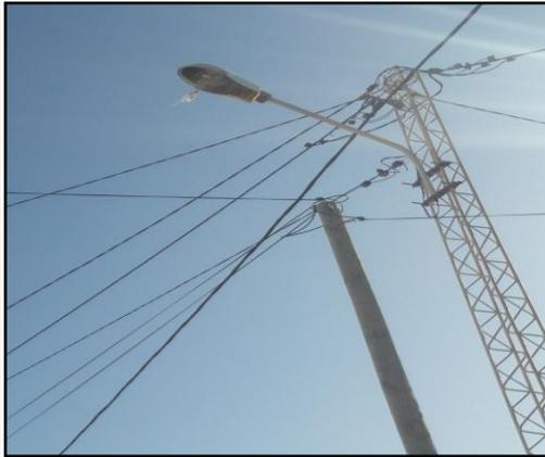
Lampe endommagée encombrement de câbles sur P-FRF
