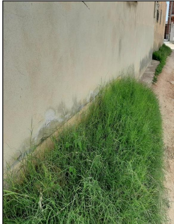
Point bleu –Trace d’efflorescence
