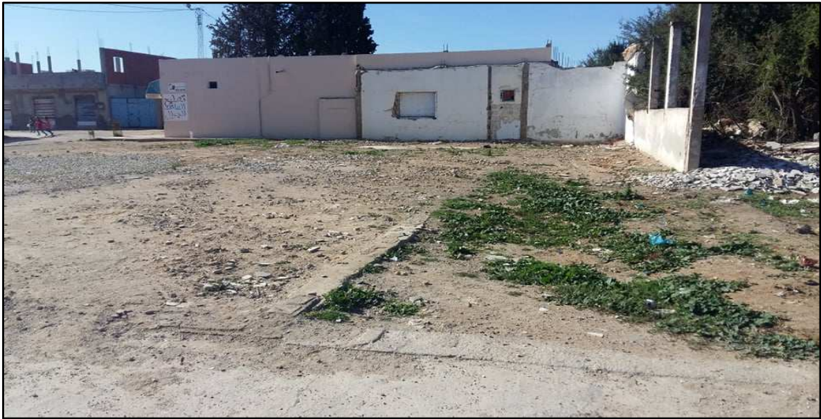
Figure 4: Site du chantier
