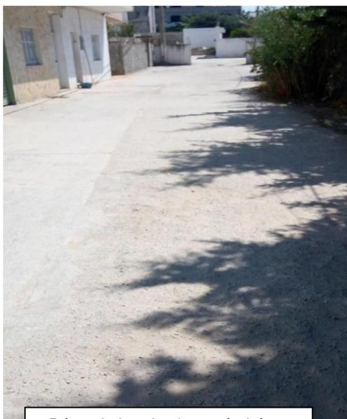
Dégradation de chaussée béton armé, absence totale des trottoirs. (Voie N°13)
