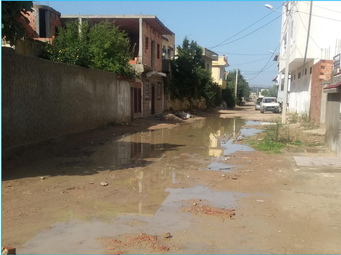
Stagnation des eaux pluviales
