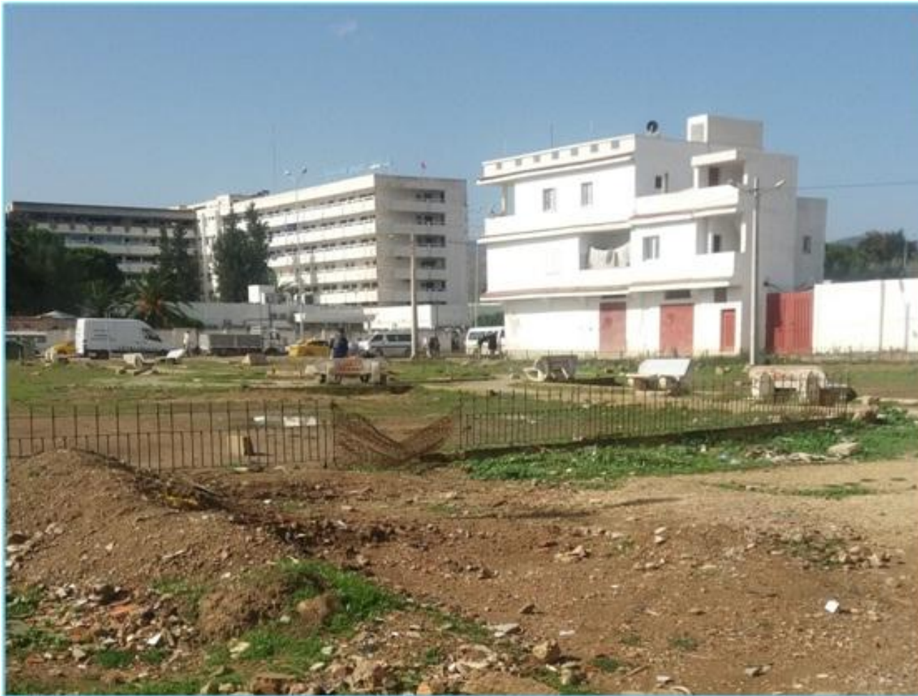
Figure 12: l'état initial d'espace vert
