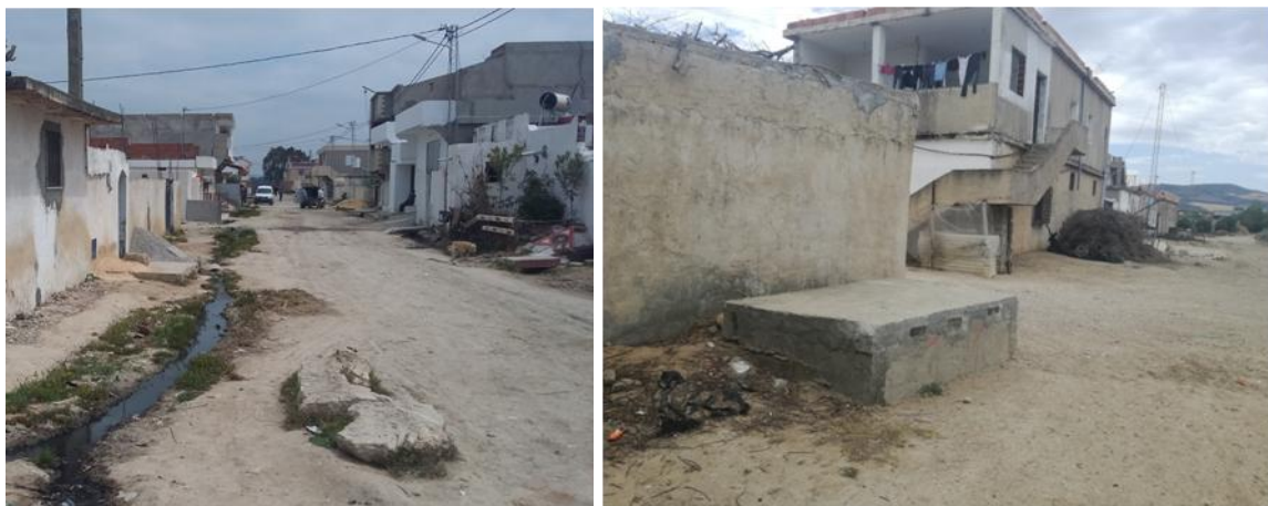
Rejet des eaux usées dans la voirie
