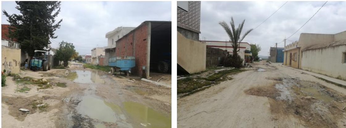
Figure 24 : Zones de stagnation à l'intérieur du quartier El Manar
