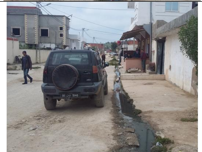
Etat actuel des ouvrages de drainage des eaux pluviales dans le quartier El Manar
