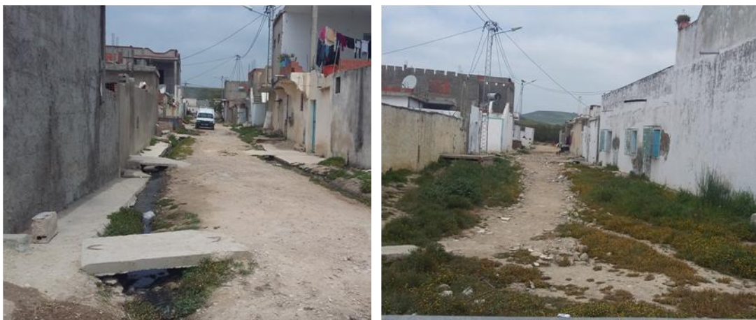
Figure 19 : État actuel de la voirie en terre dans le quartier El Manar
