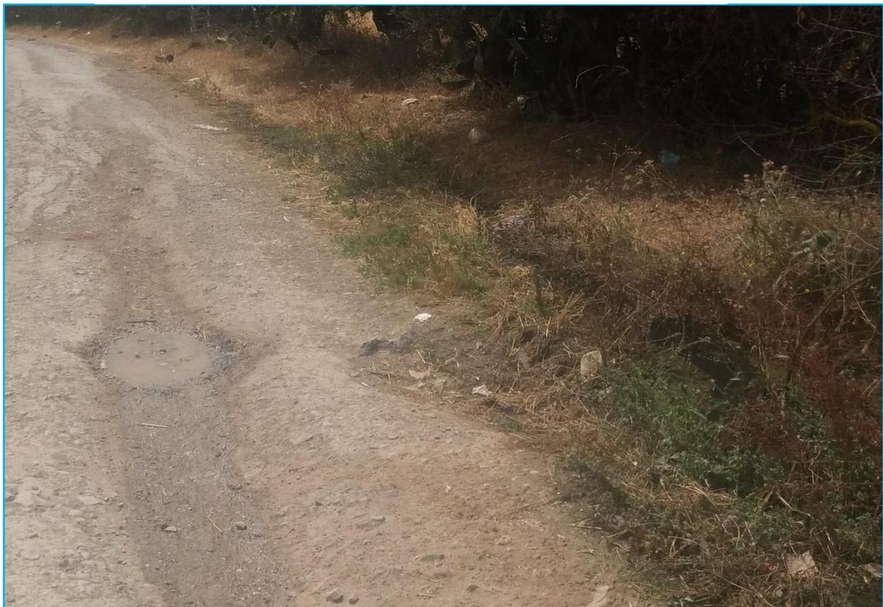
Stagnation des eaux pluviales au voisinage de la chaussée
