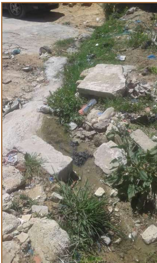
Photo 6 : Eaux grises rejetées en surface.
