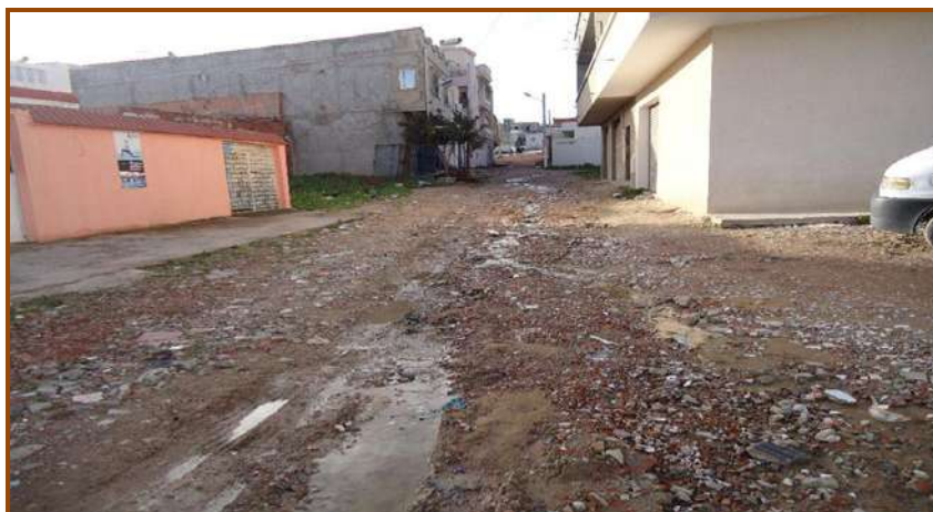
Photo 5 : Voie II en terrain nu.
