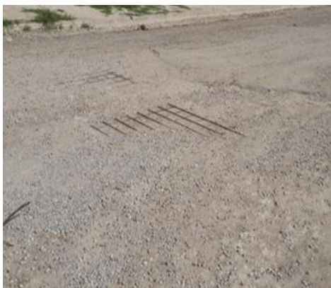
Figure 14 c : Tri couche dégradée profonde
