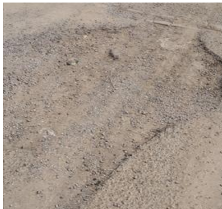
Figure 14 b : chape dégradée
