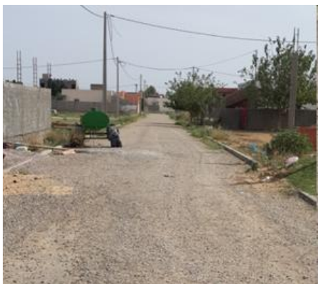
Figure 14 a : voie enrobé
