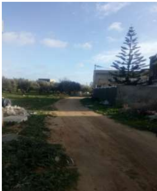
Photo 6: Rue N°43 en état de Piste
