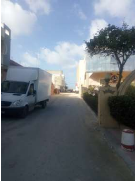
Photo 7 : Rue Tatouine revêtue en bicouche
