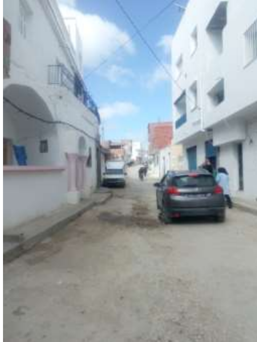
Photo 1 : Rue Tahert en état en bicouche très dégradé
