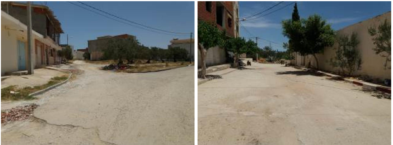
Photo.6 : Chaussée dégradées
