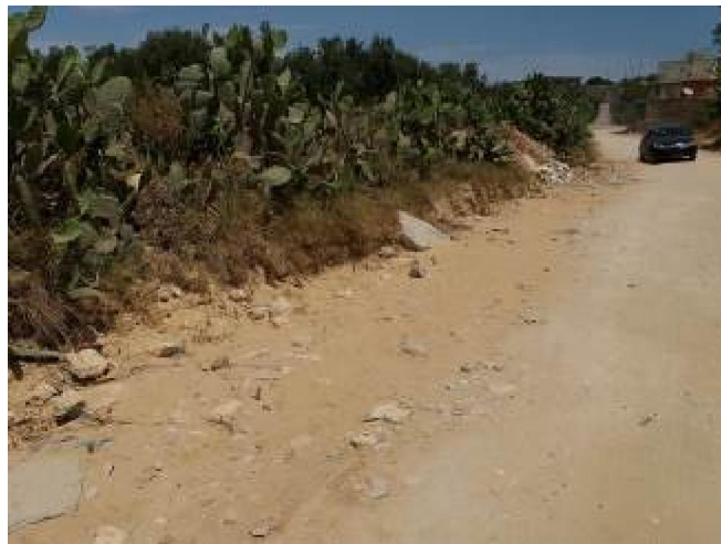
Photo.4 : Etat actuel du drainage des eaux pluviales (érosion des bords de la route)
