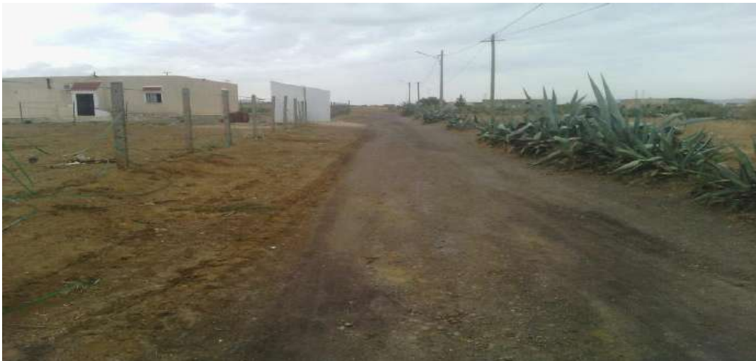
Etat actuel de la chaussée de la voie N°1(zone 3), voie en terre battue nécessitant un aménagement urgent, Zone d'Habitat individuel groupé.
