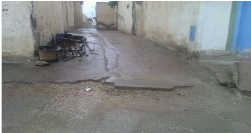
Figure 20: Branchement d'Eau Potable dans le quartier E ECHOUHADA
