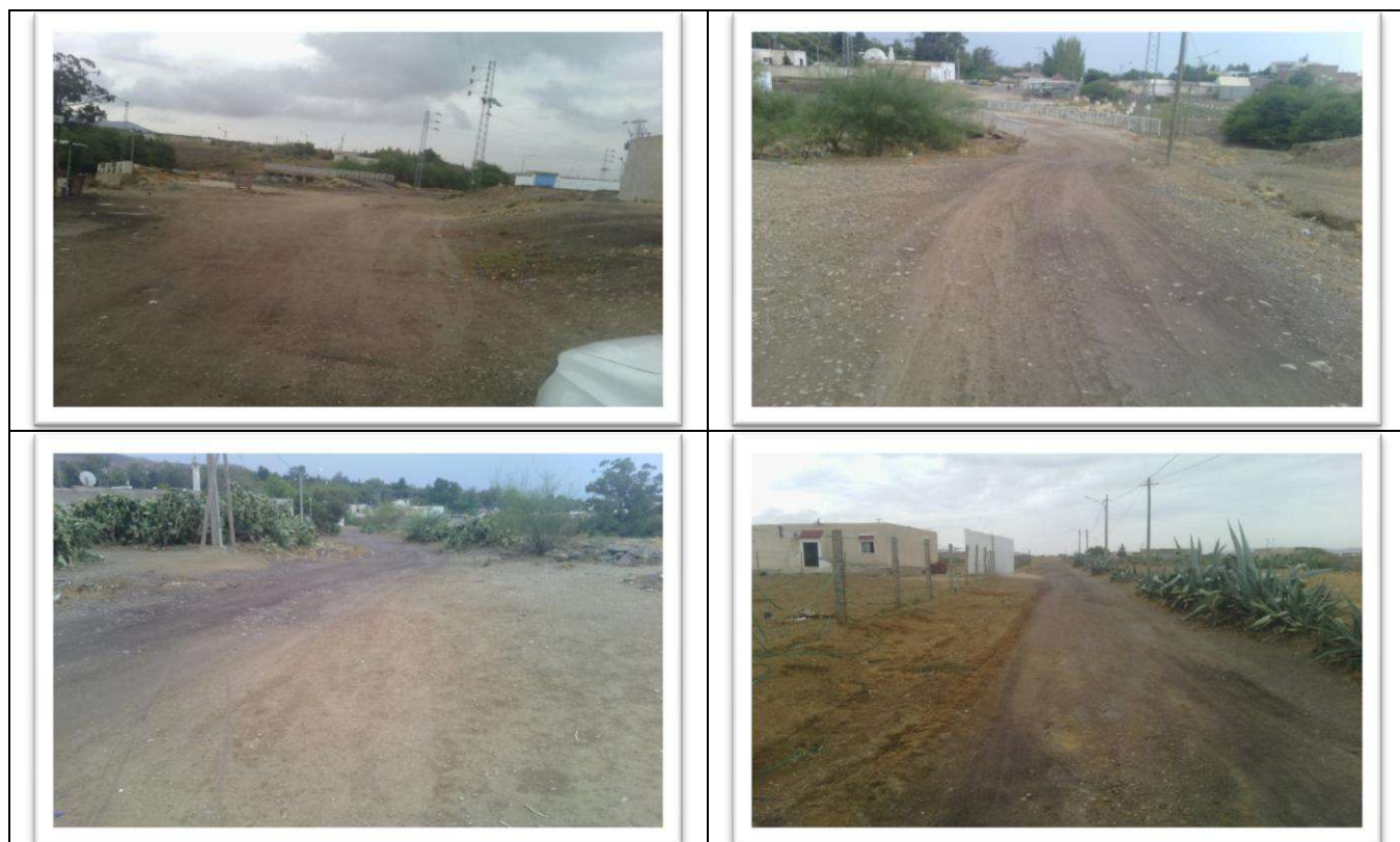
Vues de l'état actuel des rues dans le quartier Echouhada - Zone 3 : Echahid Sadok1
