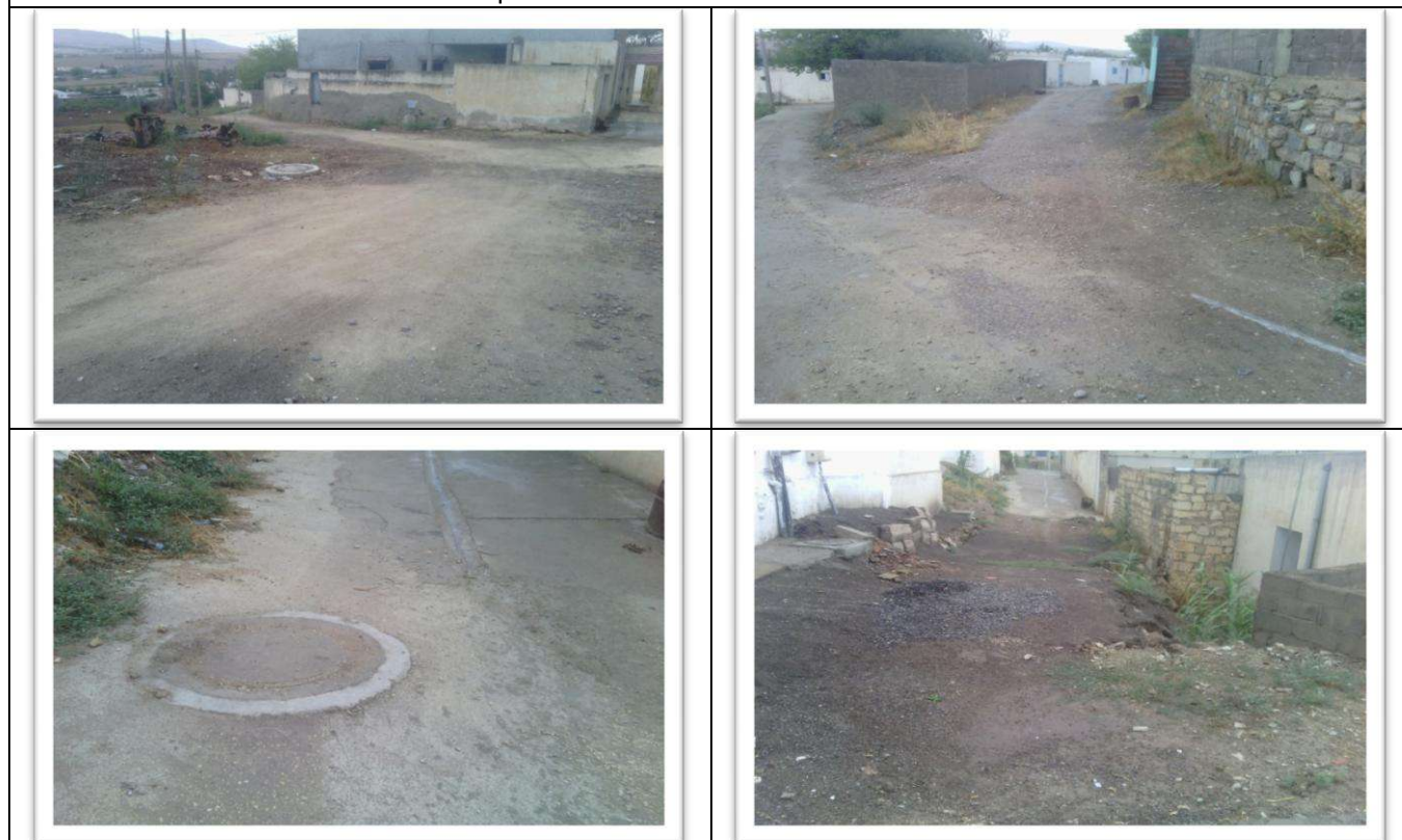
Vues de l'état actuel des rues dans le quartier Echouhada - Zone 2 : Ezzouhour
