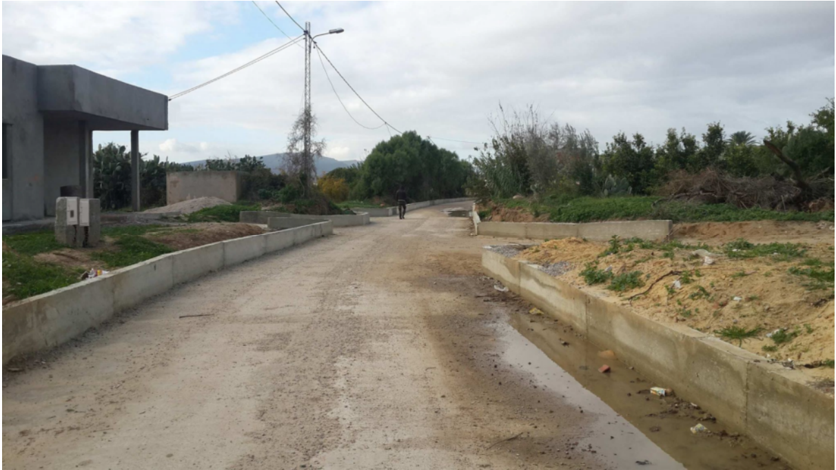
partie de rue Rourou déjà réalisée par la commune de Bou Argoub, revêtement en dallage en béton armé de 15cm forme U
