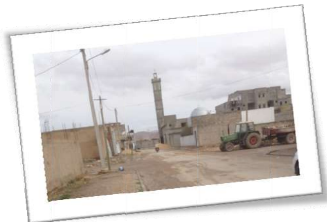
Figure 1 : état des habitations
