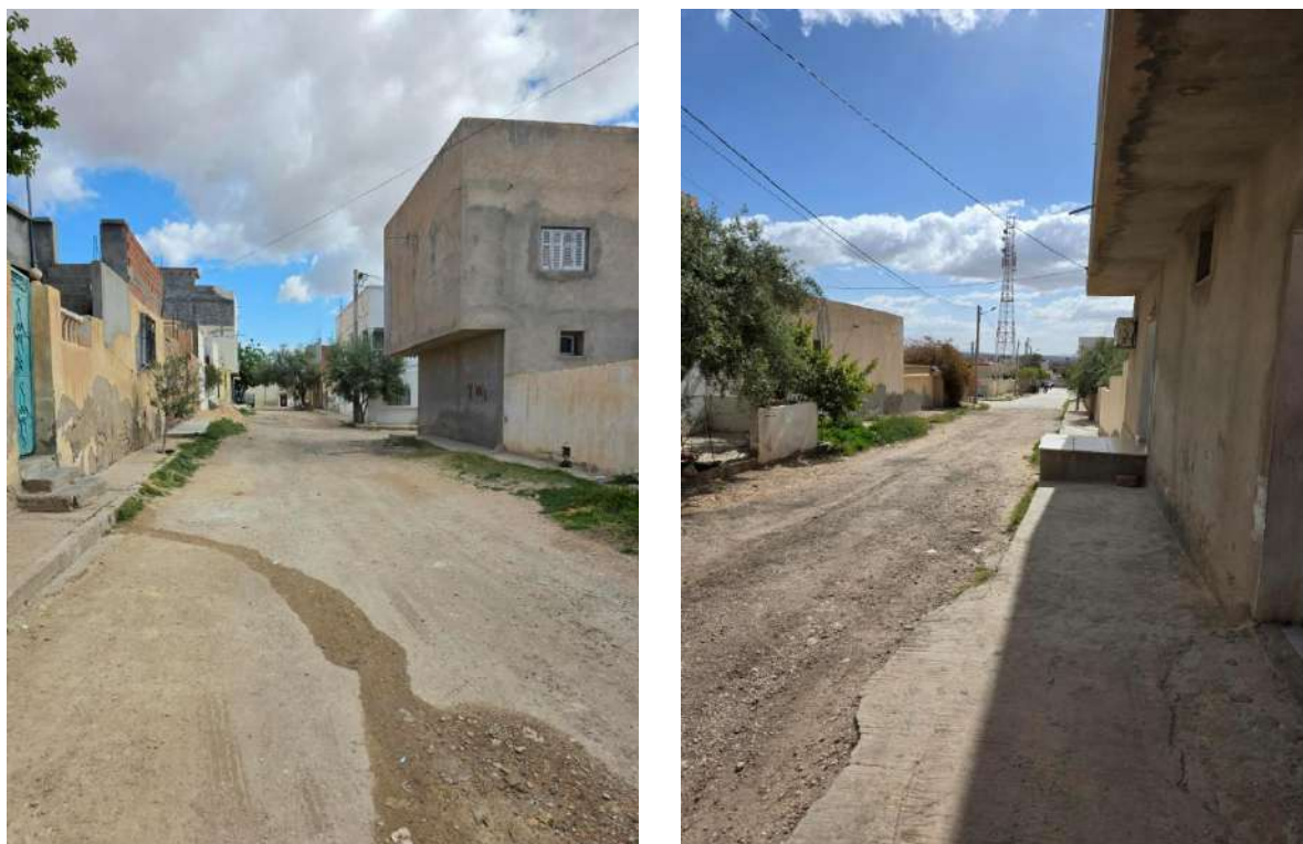
Figure 10: Chaussées en terre battue
