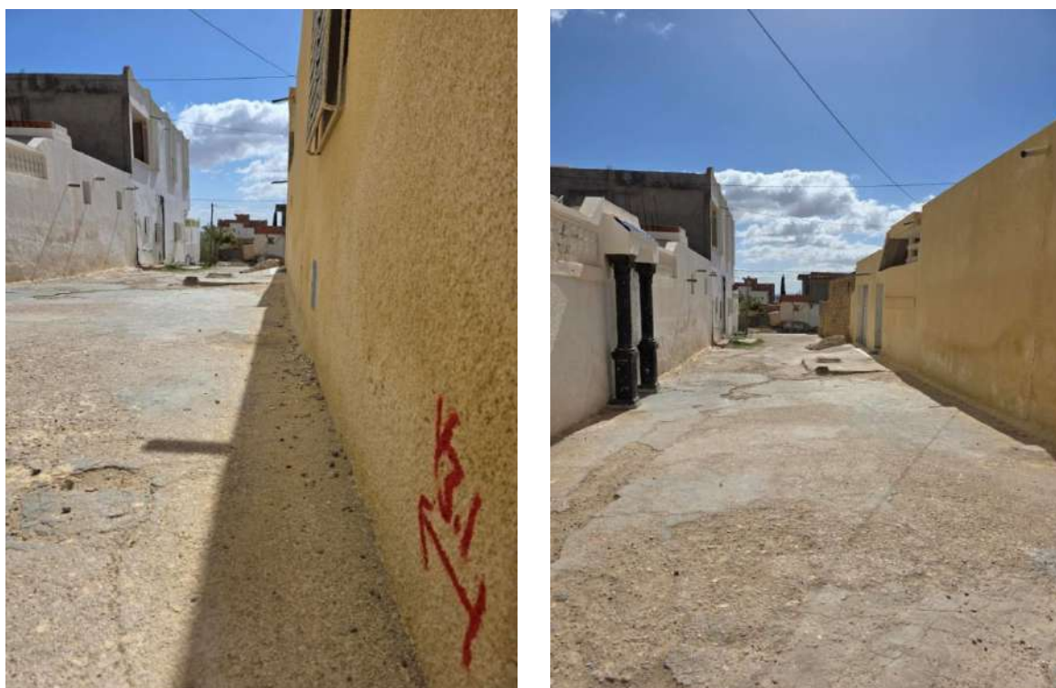
Figure 8: Chaussées en chape dégradé avec présence du nid-de-poule
