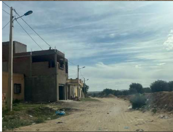
Travaux neuf : piste dépourvue de couche de chaussé
