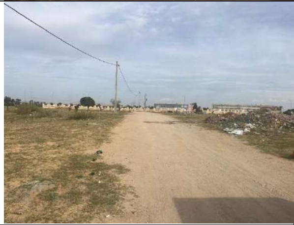
Travaux neuf : piste dépourvue de couche de chaussé
