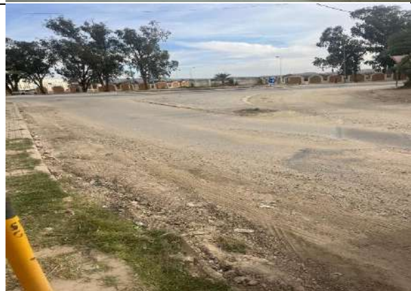
Travaux de réhabilitation : chaussée très dégradée
