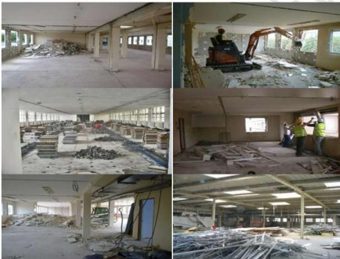
Fig.13 : Phase du curage et de tri manuel des déchets
