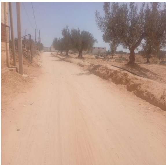
Figure 4 : chaussée en terre battue
