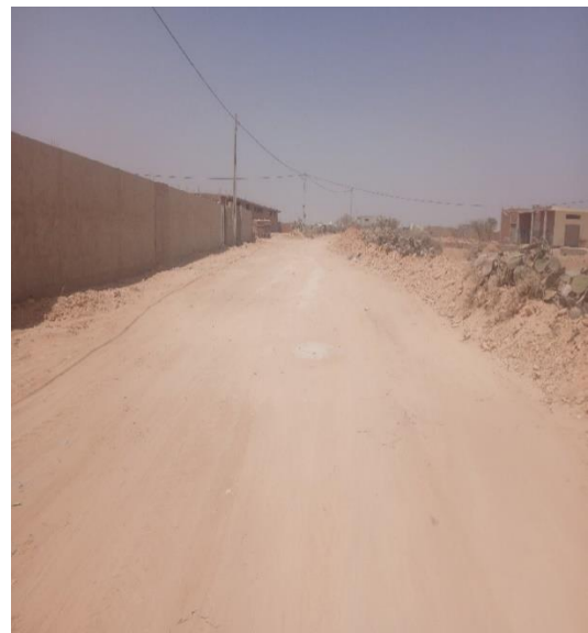
Figure 4 : chaussée en terre battue
