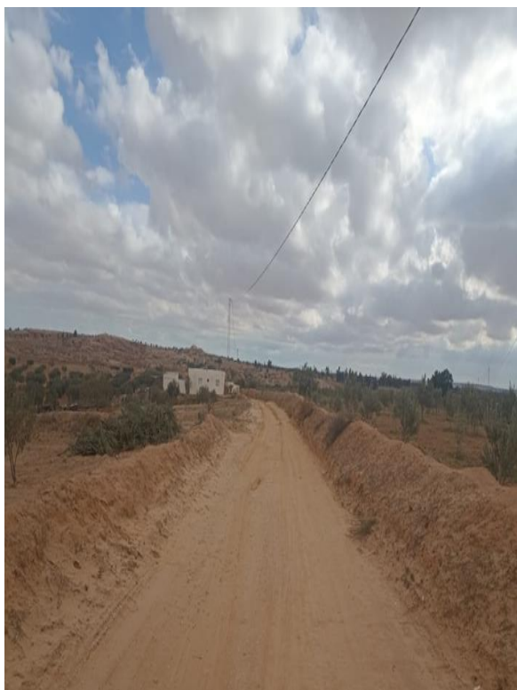
Figure 4 : chaussée en terre battue
